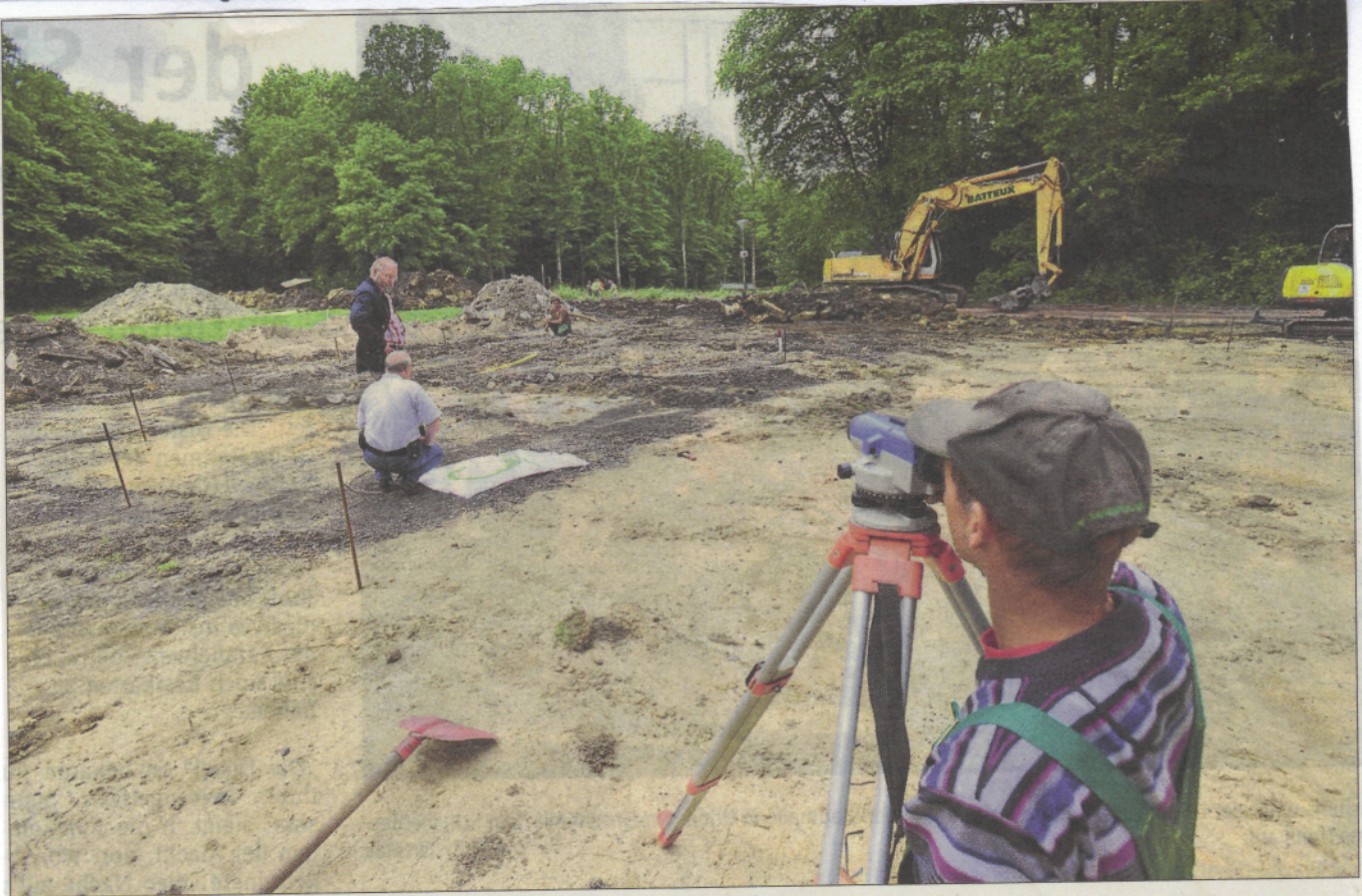
Das Tiefbauunternehmen, das die Kanalisation am Römerberg saniert, legt auch die Abwasserleitungen und die Drainage für die Einrichtungen im Archäologischen Park. Unter anderem müssen die sanitären Einrichtungen und das Amphitheater angeschlossen werden. ■ Foto: Grzelak
